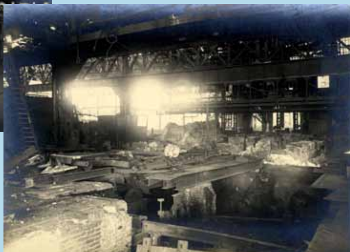
Ougrée-Marihaye. Arrière du laminoir avant et après démontage par les Allemands
