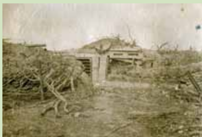
Abris à munitions après bombardement
