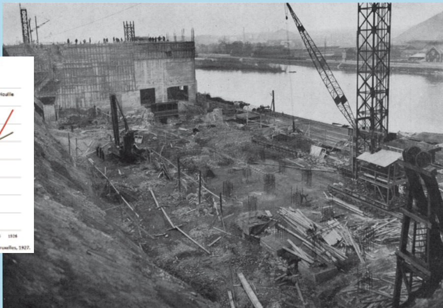
Les grands travaux exécutés à Ougrée-Marihaye
