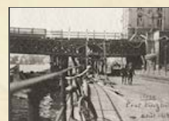
Le pont Maghin ébranlé
